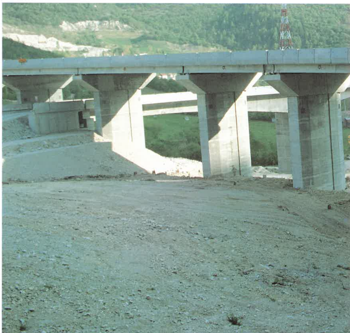
Autostrada Vittorio V.to - Pian di Vedoia Svincolo di Fadalto (TV) Impresa Condotte d'Acqua
